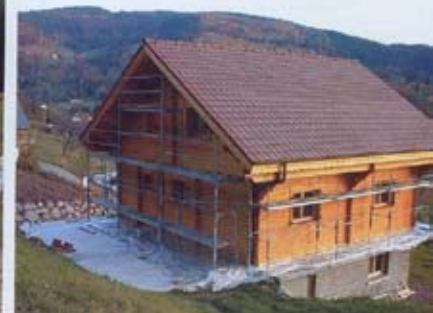
Un chef de chantier de près de 150 m 2 de plancher monté en quinze jours par trois personnes, avec l'assistance ponctuelle d'un technicien des Chalets Point. Le maître d'œuvre a construit le gros-œuvre jusqu'à la couverture puis suivi les autres corps d'état. Chalets Point.
