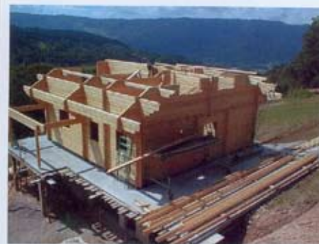
Un chef de chantier de près de 150 m 2 de plancher monté en quinze jours par trois personnes, avec l'assistance ponctuelle d'un technicien des Chalets Point. Le maître d'œuvre a construit le gros-œuvre jusqu'à la couverture puis suivi les autres corps d'état. Chalets Point.
